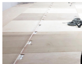
完成於夾板層上開挖線槽
