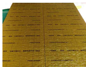
鋪設隔熱反射層
